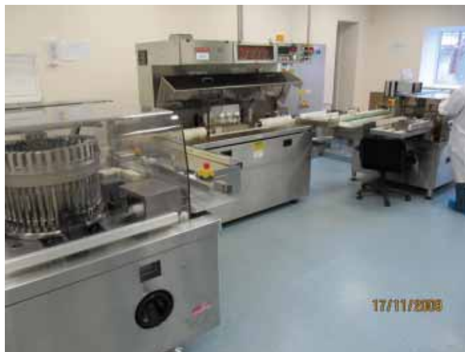
Инспекционная линия для ампул, установленная на заводе ОАО «Фармстандарт-Уфавита». Состоит из инспекционной машины Eisai AIM 588, машины проверки герметичности Bosch KLD 1040 и этикетировочной машины Bosch ERS 1020
