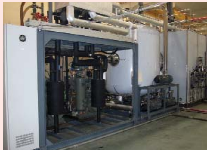
Рис. 3. Два безмасляных насоса Edwards GV 80 + механический бустерный насос
