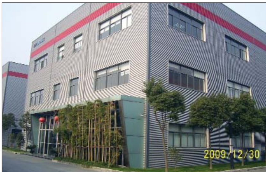
Рис. 9. Цех предприятия Shanghai KYOWAC, внешний вид здания
